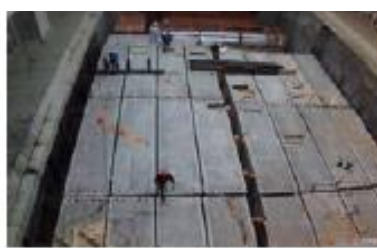
Concrete Panels 混凝土面板
